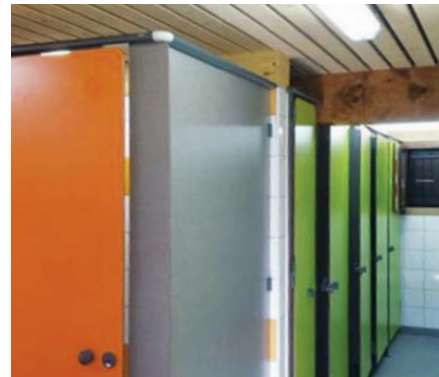
▲ EXEMPLE DE TRAVAUX RÉALISÉS EN 2015 : LA RÉNOVATION DES SANITAIRES DU CAMPING LE PELLY
