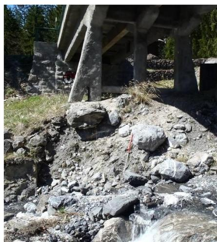
Figure 69 : atterrissement rive droite sous le pont de Feulatière
