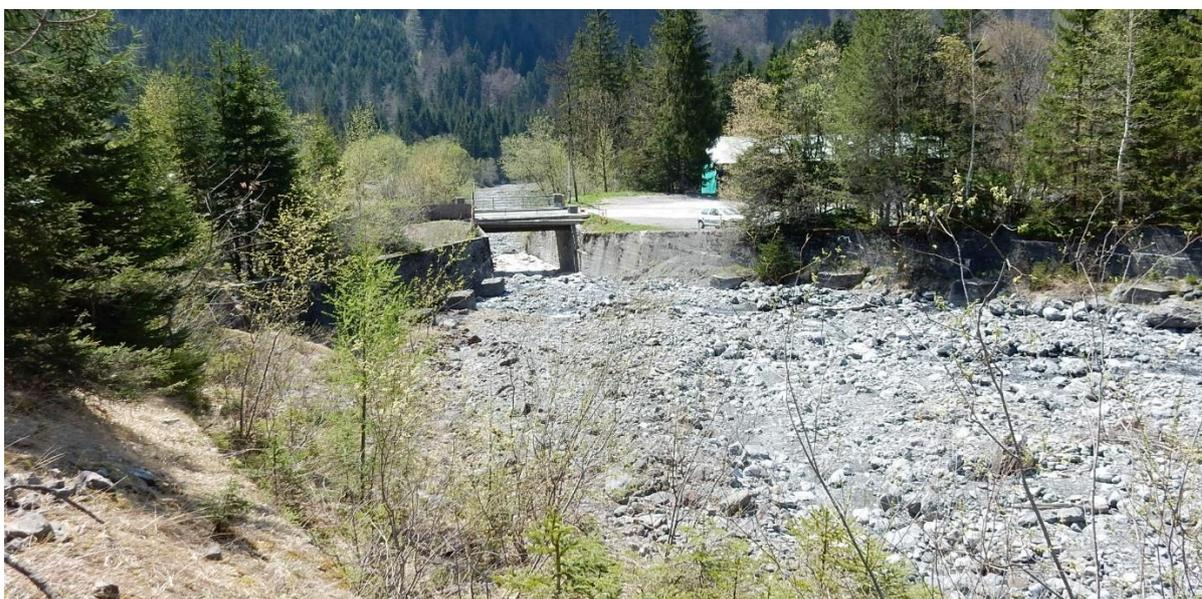
**Figure 70: entonnement du pont de la RD**
