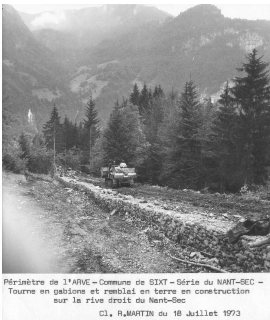
Figure 45: construction de la digue paravalanche en 1973
