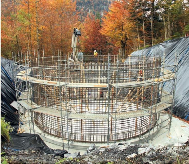
*Ce réservoir d'une capacité de 400 m<sup>3</sup> dont 120 réservés à l'incendie, alimentera en eau potable la vallée du Fer à Cheval et le village du Frénalay. Il permettra aussi de renforcer le réseau des Fardelays, en cas de besoin puisque les réseaux sont connectés.*
