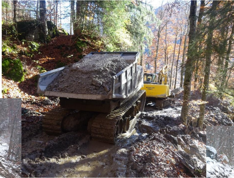
Empierrement de la piste (sur 1,7 km) et broyage (nov-dec 2020)
