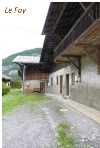
Une différenciation franche entre les soubassements maçonnés et les étages au mantelage de bois d'épicéa. Une toiture rectangulaire avec un débord plus important sur la façade aval pour abriter les loges.
