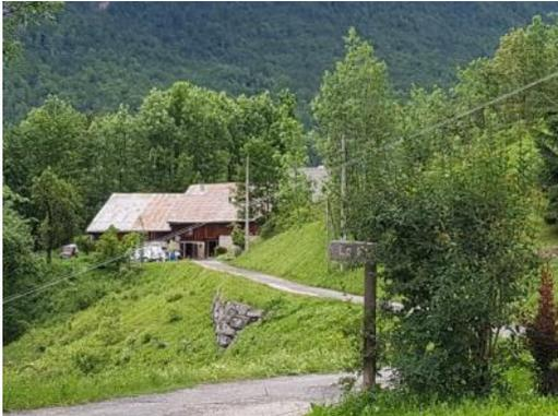
Un bâti qui « colle » à la pente naturelle : aucun talus, aucun mouvement de terre, peu de murs de soutènement.
