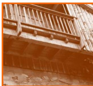
Les balcons dont le débord nécessite la réalisation en béton et le rajout de poteaux maçonnés.
