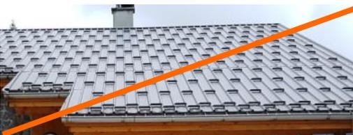
Si la tôle ondulée est toujours commercialisée il existe aussi des **bacs gris zinc, au profil style joint debout**, qui, équipés de barres à neige, sont plus proches de la tôle ondulée.
