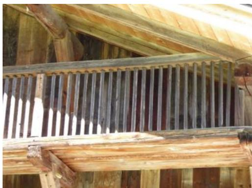
Le garde-corps de la vallée du Giffre n'a pas de lisse basse, les montants sont fixés directement dans les poutres du balcon. Il a une seule lisse horizontale d'appui. Le balcon est porté par des consoles qui sont fixées sur les poteaux structurels de la façade en ossature bois, donc jamais sur de la maçonnerie et jamais avec des consoles qui comportent des bois verticaux intermédiaires.
