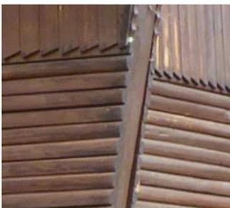
*Le Vivier* : Ci-contre détail de parement bois en dosse et finition en dents de scie du bardage vertical
