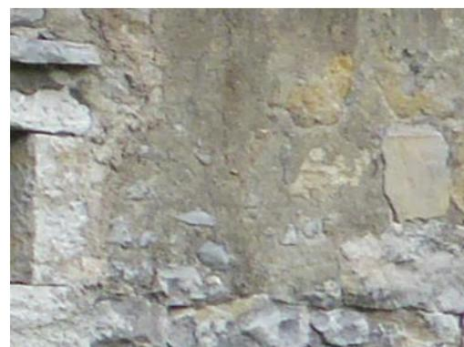
Les enduits anciens qui ont été conservés, qui sont centenaires ou plus, présentent des signes de dégradations qui laissent les pierres de murs semi-apparences. Réaliser aujourd'hui une façade avec un enduit « à pierre vue » signifie que l'on vient talocher l'enduit, voire le passer à l'éponge, en le serrant pour faire ressortir les pierres qui affleurent.
