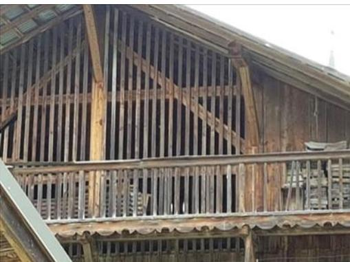
Les claires-voies sont généralement disposées en partie haute des pignons mais l'on peut en trouver dans d'autres configurations.
