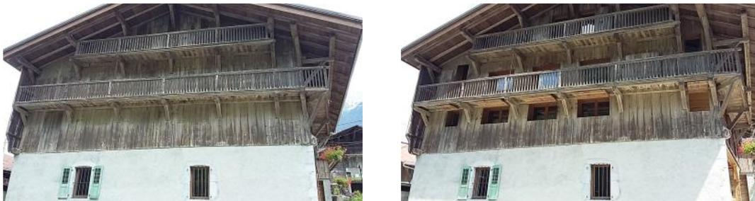
Vues volets fermés/ volets ouverts. Cette intervention a conservé les balcons de séchage à leur niveau d'origine. Les volets, créés dans les planches du bardage, sont conçus pour être invisibles en position fermée. Pour cela, les baies ne comportent pas d'encadrements saillants, les volets sont traités en panneaux rapportés ou abattants.
