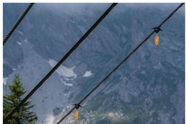
*Illustration : Exemple de visualisateur (Birdmark®) sur un câble de remontée mécanique © PN Vanoise*
