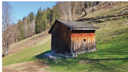
Le pressoir avant travaux
