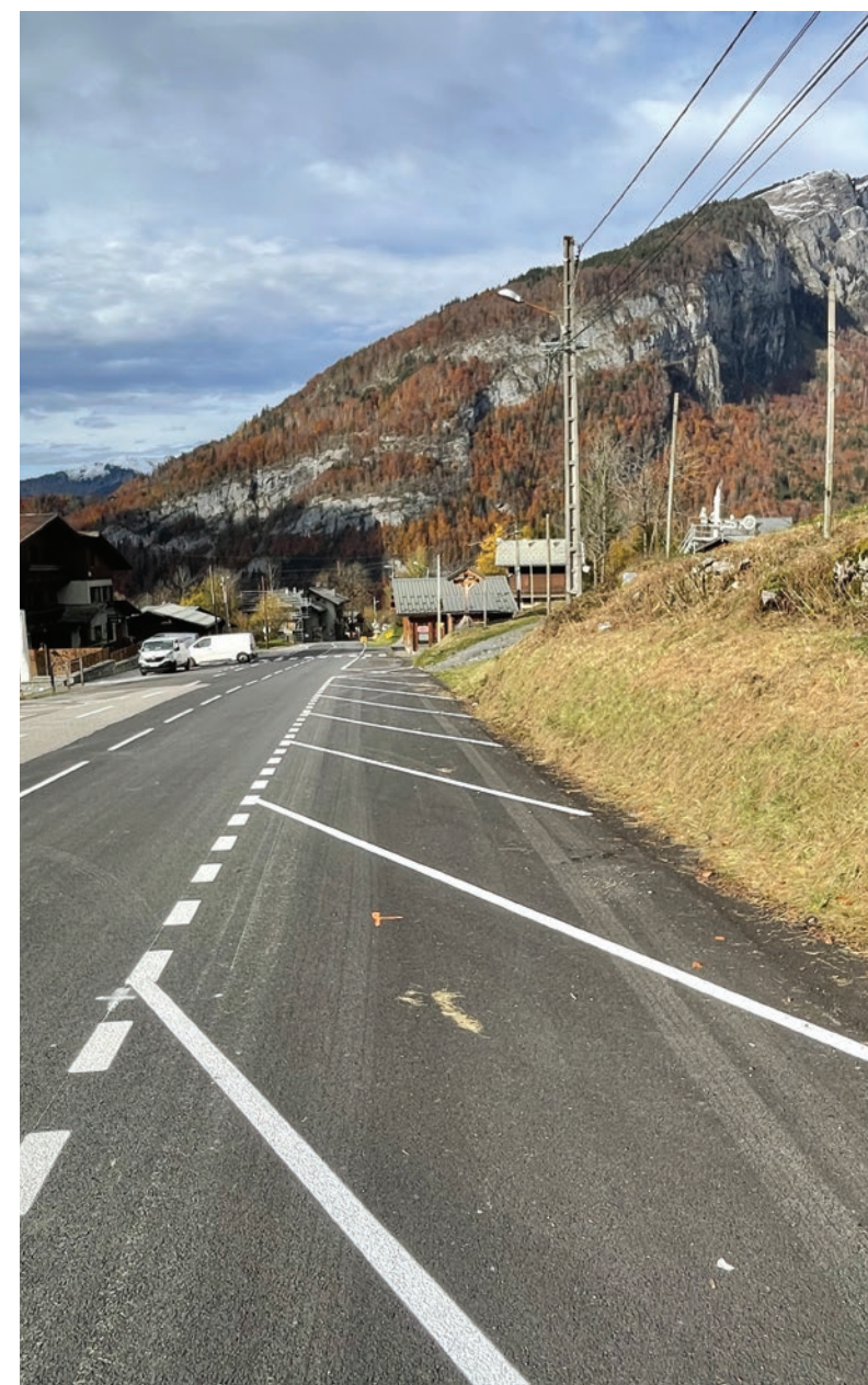
Un marquage au sol efficient pour le parking du domaine skiable
