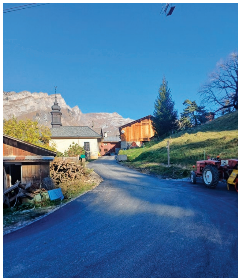
Chantier de Passy
