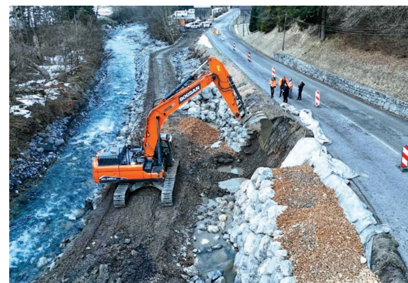
Chantier d'enrochement pour conforter la RD907 à hauteur du Vivier, par le Département de la Haute-Savoie
